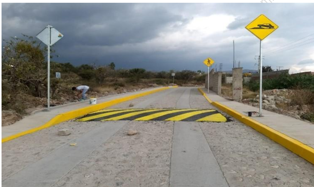
Obra terminada calle principal de Carbonera 2 da etapa.
