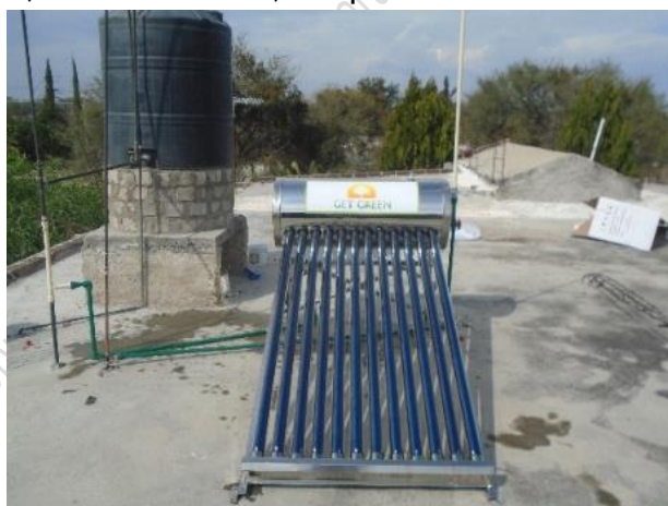
Calentador solar totalmente instalado y en operación.
