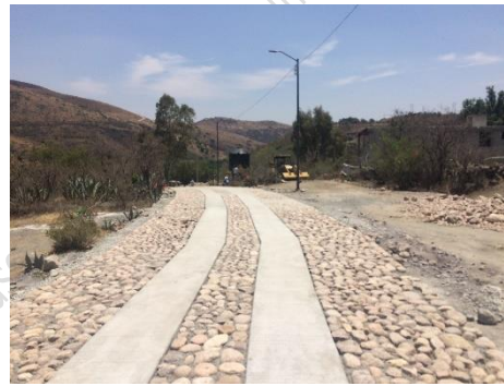
Construcción de camino con pavimento de piedra bola y huella de concreto, tramo: km 0+000 al 0+684.97, en la Comunidad El Cedro del Municipio de Guanajuato. ( Pavimento con huellas de concreto y piedra bola ).
