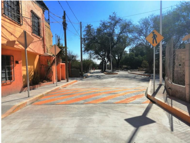
Obra terminada de pavimentación de calles Yerbabuena, Eucalipto, Paraíso y Arroyo Verde
