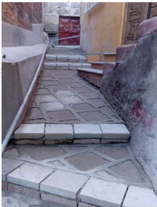
Rehabilitación de instalaciones existentes en callejones de Pardo, Las Flores y Animas.
