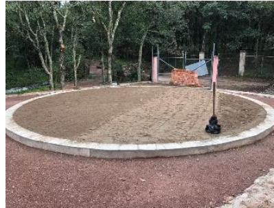
Construcción de Tanque de almacenamiento de agua potable para el abastecimiento de la Comunidad Monte de San Nicolás y Santa Rosa, en el Municipio de Guanajuato. ( Base y aro para recibir tanque ).
