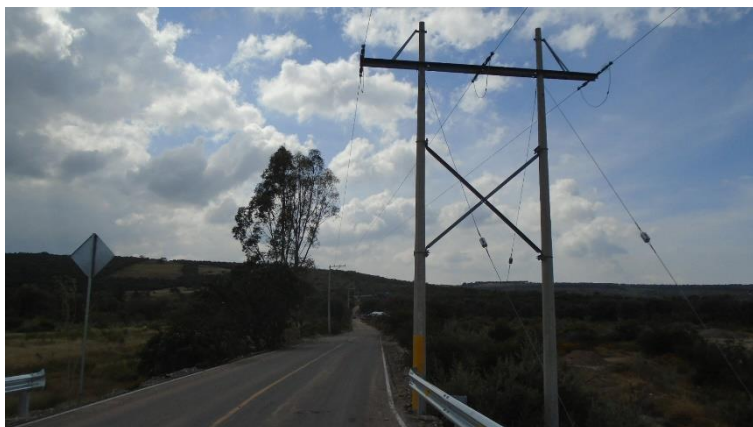
Esta obra se ejecutó como una obra complementaria a la construcción de puente vehicular El Chapín.
