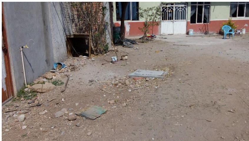
La red de distribución de agua potable en San José de Llanos 4ta. etapa.
