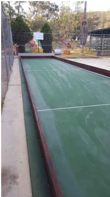
Construcción de cancha de bochas en Unidad Deportiva Torres Landa con recubrimiento sintético y tabloncillos de madera en el perímetro.
