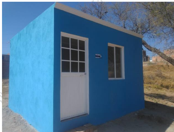
Cuarto dormitorio terminado.
