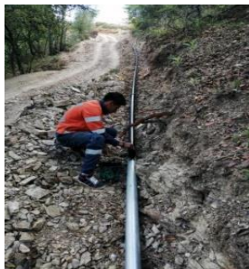
Rehabilitación de línea de distribución de agua potable, tramo km 0+000 al km 0+2342, en la comunidad de Monte de San Nicolás, en el Municipio de Guanajuato. ( Instalación de tubería de fierro galvanizado ).
