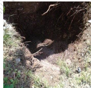
Rehabilitación de la red de bombeo de planta potabilizadora, de filtros a tanque Borrego para el abastecimiento de agua potable en las comunidades de Mineral de Santa Ana y Llanos de Sta. Ana, en el Municipio de Guanajuato. ( Excavación para colocar equipo de bombeo ).
