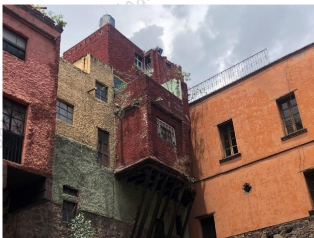
Inmueble con alto riesgo de colapso ubicado en Avenida Juárez 120, vista desde la Calle Miguel Hidalgo (Subterránea).
