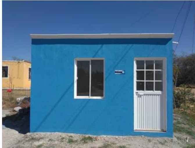
Cuarto dormitorio terminado.
