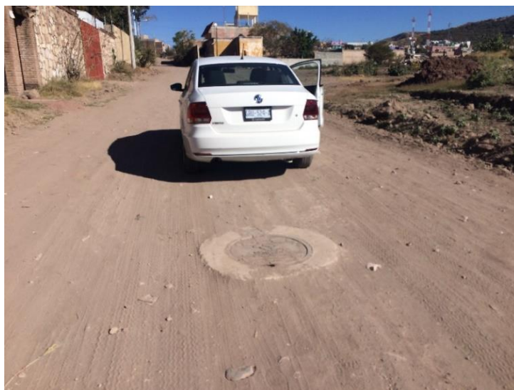
Obra terminada del colector sanitario Deportiva Yerbabuena.
