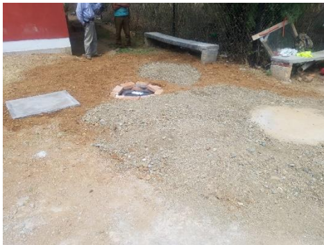
Construcción de sistema de tratamiento de agua residual mediante biodigestor y pozo de absorción en la comunidad de Mexiamora, en el Municipio de Guanajuato. ( Obra terminada ).
