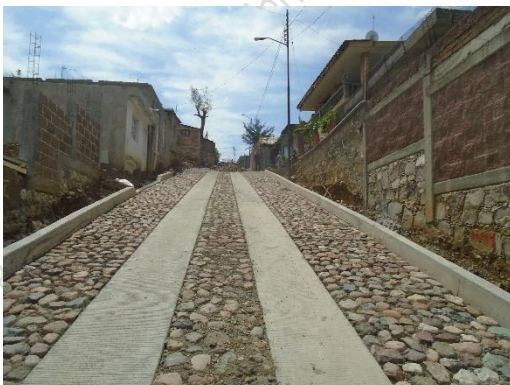
Construcción de calles sin nombre con pavimento de piedra bola y huella de concreto, tramo: km 0+000 al 0+163.93 y 0+000 al 0+109.39 en la Comunidad San Pedro Gilmonene del Municipio de Guanajuato.
