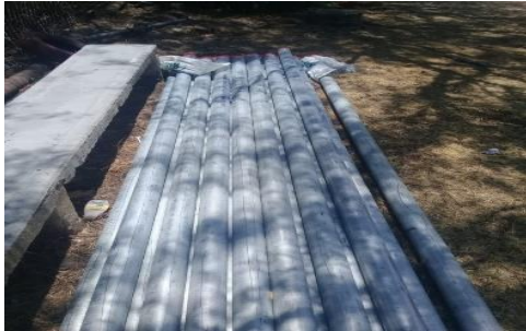
Construcción del equipo de bombeo, cloración y línea de conducción de agua potable en la Comunidad de Mexiamora, en el Municipio de Guanajuato. ( Suministro de tubería ).
