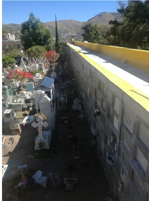
Rehabilitación de cantera en gavetas; retiro de maleza, rehabilitación, impermeabilización y pintura de cubierta en gavetas en Muros del Panteón de Santa Paula.
