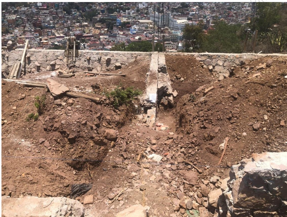
Suspensión de obra en cerro de San Miguel por construcción de elementos no autorizados por la Dirección de Imagen Urbana.
