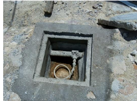
Rehabilitación de Línea de Distribución de agua potable, tramo km 0+000 al km 0+332.59, en las Comunidades de Mineral de Santa Ana y Llanos de Santa Ana, en el Municipio de Guanajuato. ( Instalación de toma domiciliaria para agua potable y construcción de registro ).
