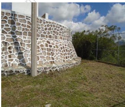
Rehabilitación de tanque Borrego para el abastecimiento de agua potable a las
