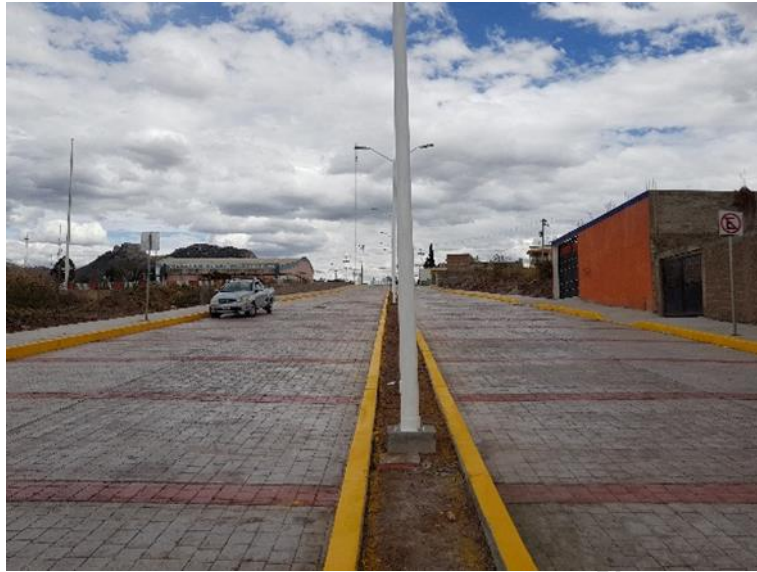
Calafateo de cortes en pavimento de concreto hidráulico en calle Biznaga.
