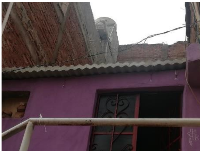
Techo firme terminado a base de lámina de fibrocemento y material aislante de poliestireno, incluye montén.
