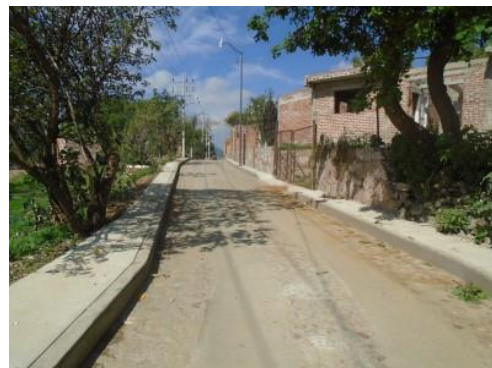
Construcción de calle sin nombre con pavimento de piedra bola y huella de concreto, tramo: km 0+000 al 0+419.22 en la Comunidad Sangre de Cristo del Municipio de Guanajuato. ( Obra concluida: Pavimento con huellas de concreto y
