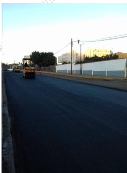
Revestimiento Mezcla asfáltica Avenida Santa Fe.
