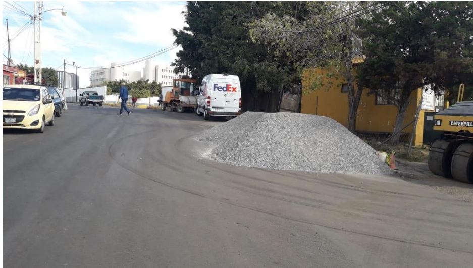
Bacheo en Camino a Cata, pasando el Instituto Ignacio Montes de Oca.
