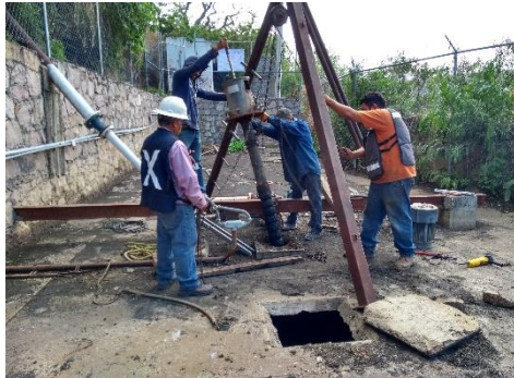
Rehabilitación de cárcamo de bombeo de aguas residuales y de PTAR (RAFA) en la comunidad de Mineral de Santa Ana, en el Municipio de Guanajuato. ( Maniobras para retiro de equipo dañado para su reparación ).
