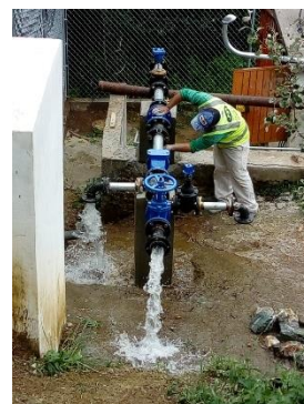
potabilizadora en comunidad Mineral de la Luz,
