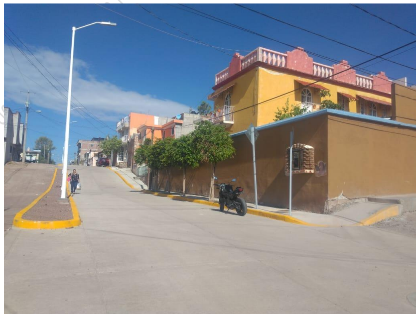
Obra terminada de Pavimentación de calle Plan de Ayala.
