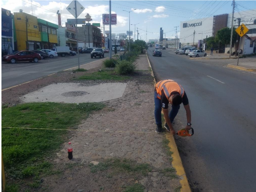
FIGURA 27. Levantamiento glorieta puentecillas.
