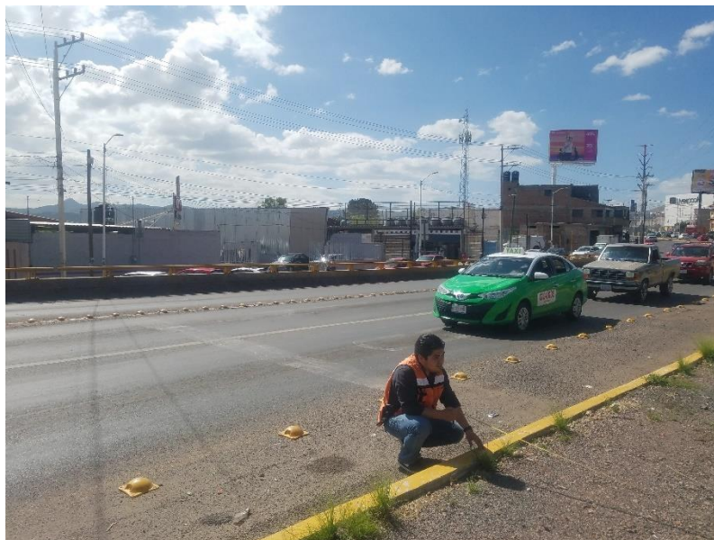
FIGURA 28. Levantamiento Glorieta Puentecillas.
