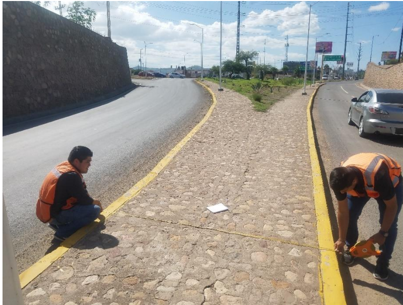
FIGURA 29. Levantamiento Glorieta Puentecillas.
