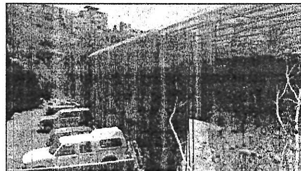
Fotografía # 9 y 10.- Origen de los daños, por el movimiento de tierras y su compactación, ya que los muros son de carga, no son muros de volteo o contención.
