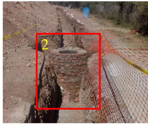
Evidencia fotográfica donde se ilustra el proceso de ejecución de los pozos de visita. Se visualiza que no se realizó el aplanado de dichos pozos por la parte exterior. En fotografías 1 y 2 se visualiza el pozo de visita solo con aplanado interno.
