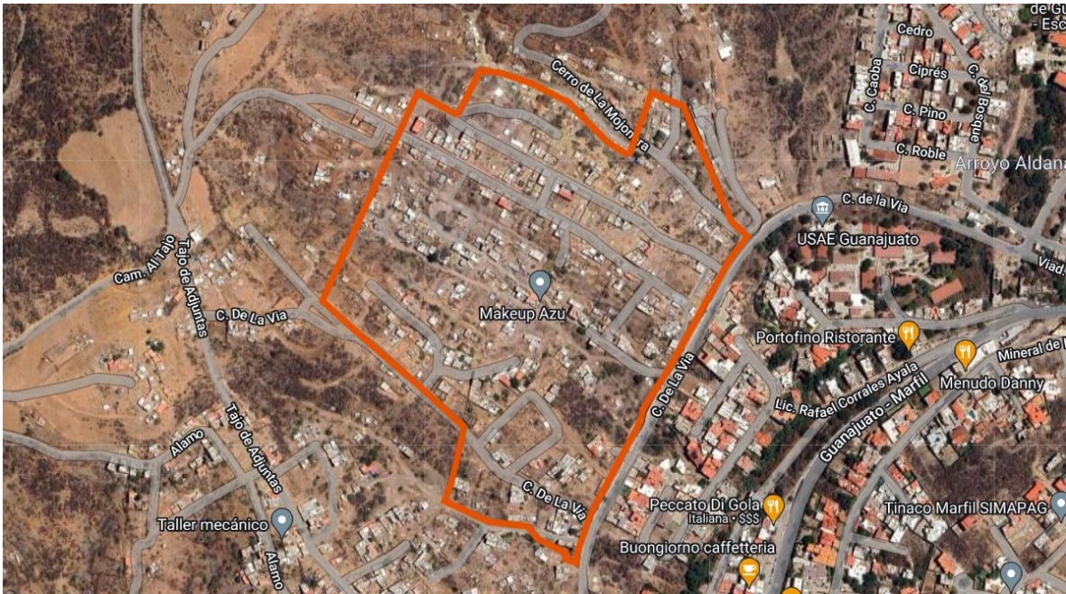
Imagen 1. Imagen ilustrativa de construcciones existentes dentro del polígono de PRESAS DE GUANAJUATO. (Fuente: Levantamiento en dron efectuado por el Instituto Municipal de Planeación, Dirección de Administración Urbana, 2022).
