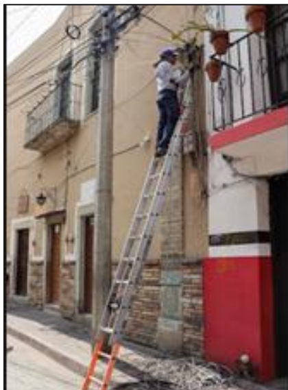
Imagen 16. Obras de Retiro de Cableado en Vía pública.
